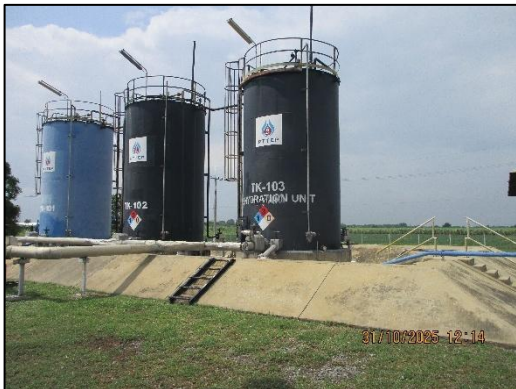
ภาพถ่ายที่ 2.2-7 คันคอนกรีตล้อมรอบถังเก็บ
