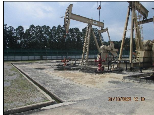
ภาพถ่ายที่ 2.2-6 บ่อคอนกรีตเก็บน้ำ (Concrete Pit) และรางระบายน้ำล้อมรอบพื้นที่ผลิต
