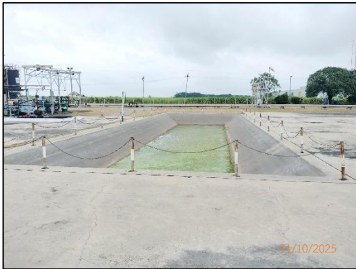
ภาพถ่ายที่ 2.2-6 บ่อคอนกรีตเก็บน้ำ (Concrete Pit) และรางระบายน้ำล้อมรอบพื้นที่ผลิต
