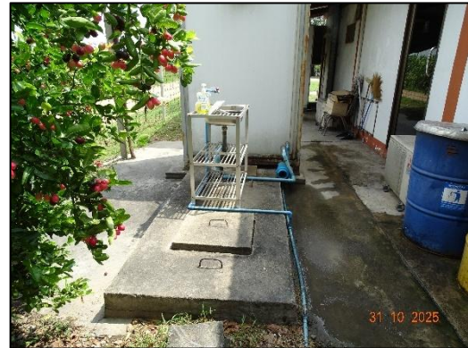
ภาพถ่ายที่ 2.2-5 ห้องสุขาและบ่อเกรอะในพื้นที่ฐานหลุมผลิต
